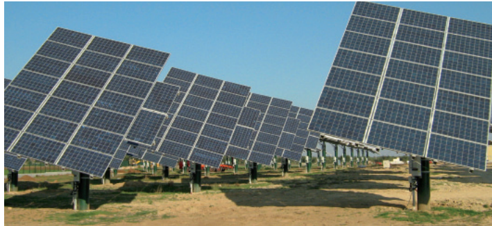
Campo Solare ad inseguimento biassiale con potenza pari a 1,3 MW, Racale (LE)
