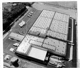
Lidi ha già fatto esperienze come produttore di corrente da fonte fotovoltaica: qui, l'espansione di Herten, in Germania.
