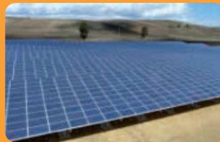
IMPIANTO FOTOVOLTAICO SU PENSILINE IN SICILIA 750 kWp
