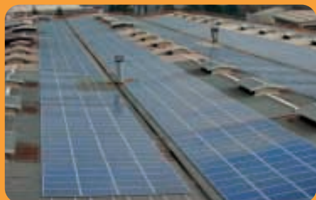
COPERTURA INDUSTRIALE 1 MWp
